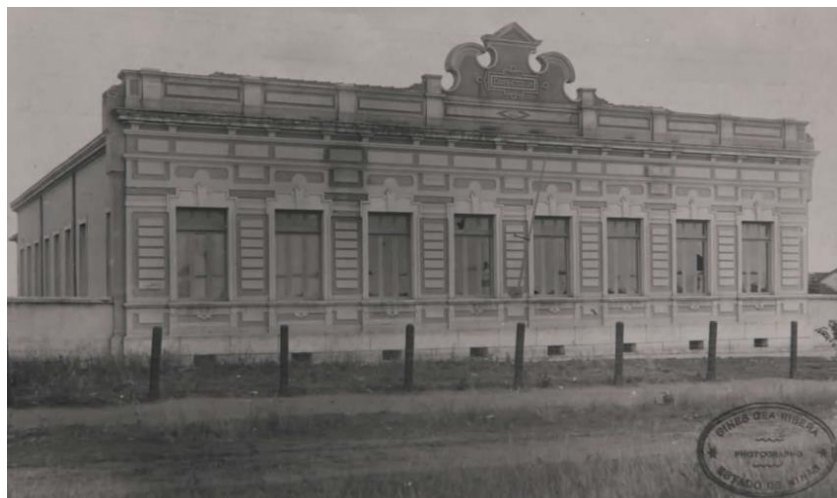
Figura 1 – Fachada do prédio do Grupo Escolar Júlio Bueno Brandão 6 . Fonte: Arquivo Público de Uberlândia — fotógrafo e data não identificados.
