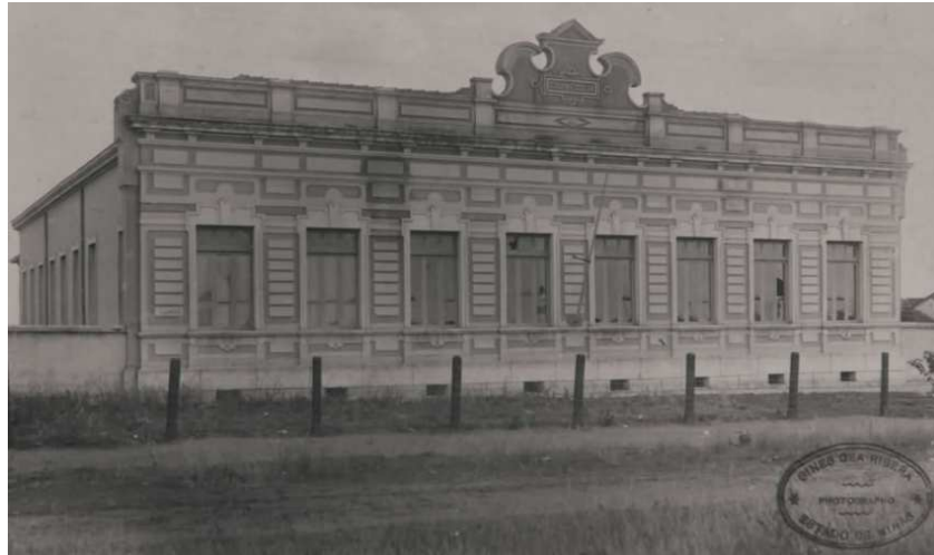
Figura 1 – Fachada do prédio do Grupo Escolar Júlio Bueno Brandão 6 . Fonte: Arquivo Público de Uberlândia — fotógrafo e data não identificados.
