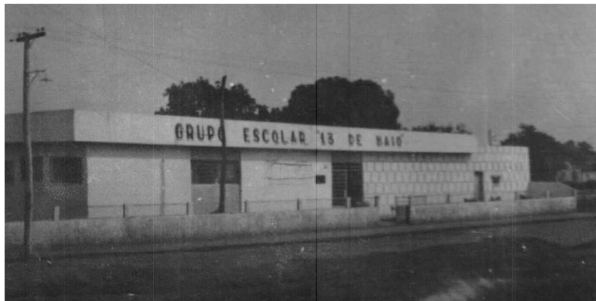
Figura 2 – Fachada do prédio próprio do Grupo Escolar 13 de Maio. 7 Fonte: Escola Estadual 13 de Maio — fotógrafo e data não identificados.
